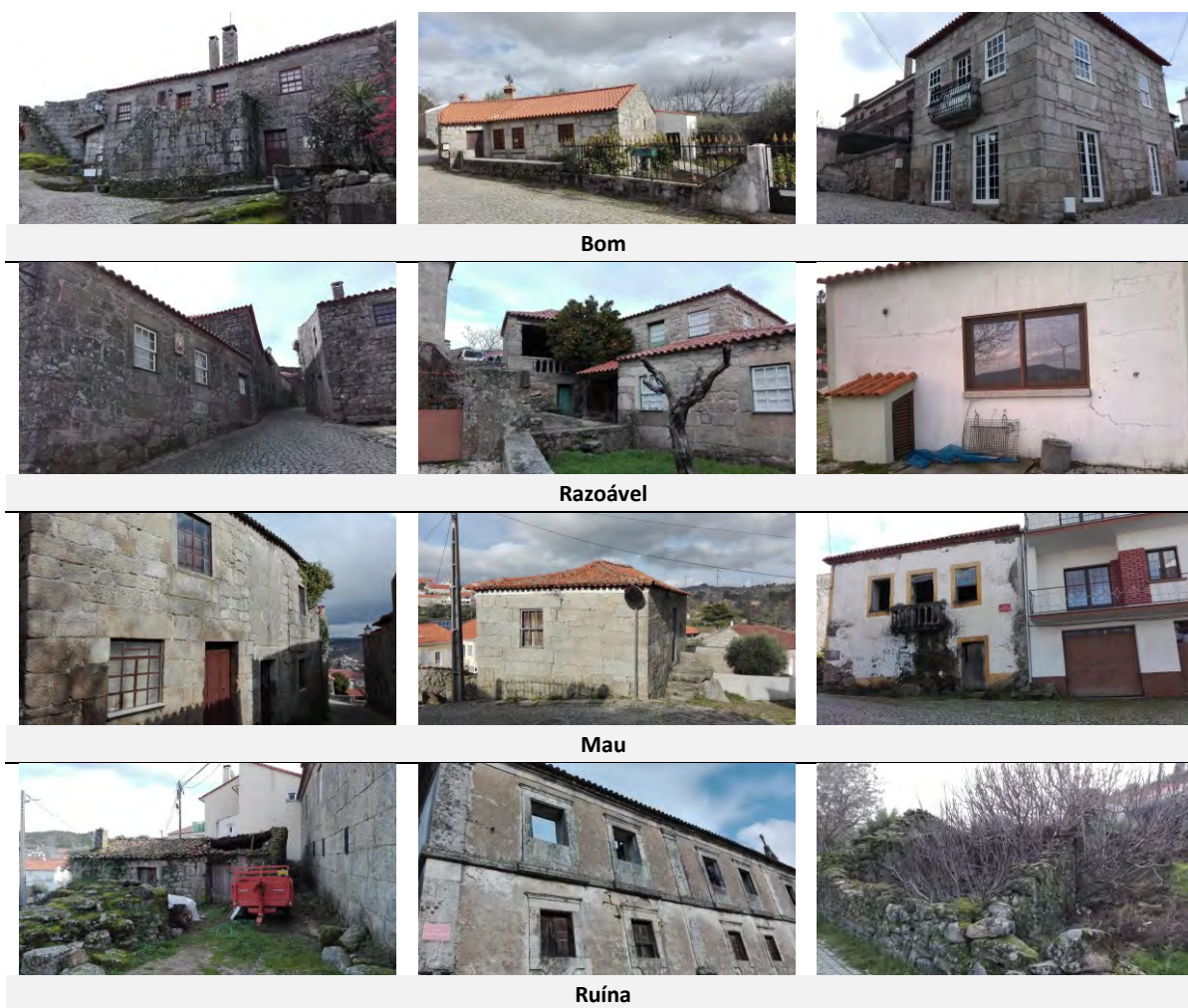
Figura 14. Exemplos de edifícios presentes na ARU de acordo com o seu estado de conservação
