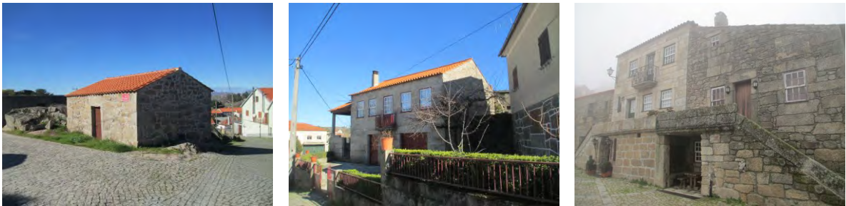
Figura 27. Exemplos de volumetria do edificado da ARU
